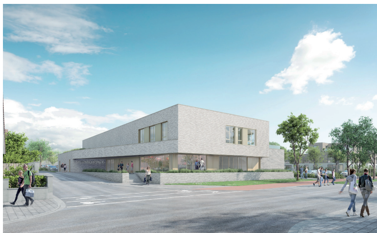
CONSTRUCTION DE LA MAISON DE SERVICES
