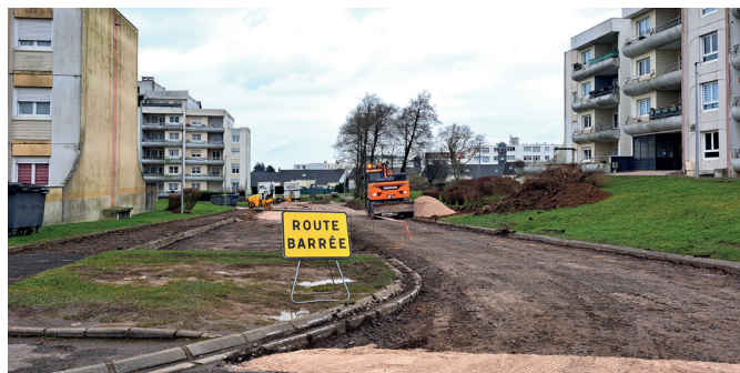
PARKING RÉSIDENCES DES NAVIGATEURS EN COURS
