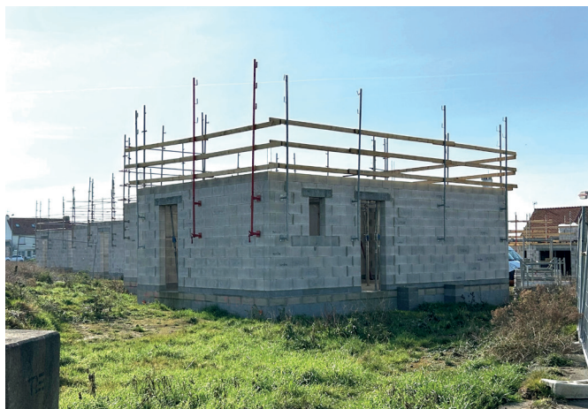
CONSTRUCTION DES 9 LOGEMENTS EN LLS
